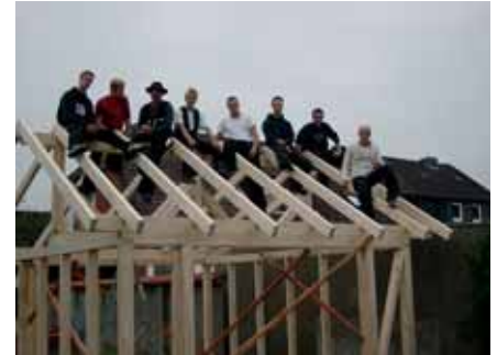
Nach dem Richten der Hölzer
