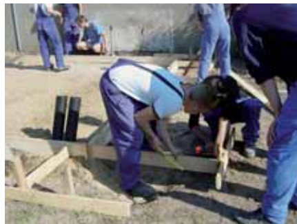
Einschalen der Sohlplatte
