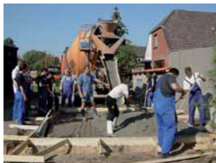
Der Beton kommt!
