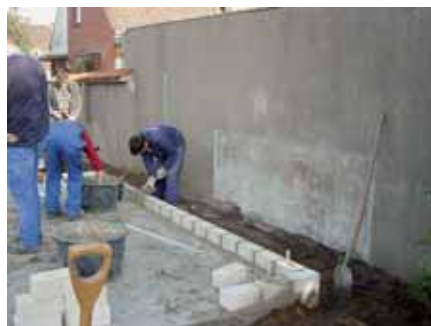
Mauern des Sockels
