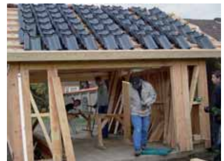
Anbringen der Lärchenschalung
