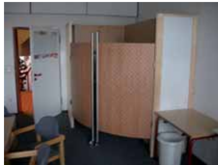
Abtrennung der Küchenzeile im Konferenzraum-Pendeltürelemente in Bogenform
