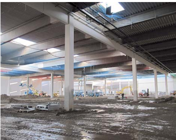
Die Hallen im Rohbau
