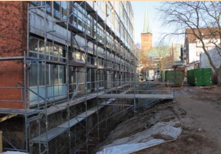
Die Baustelle Dankwartsgrube
