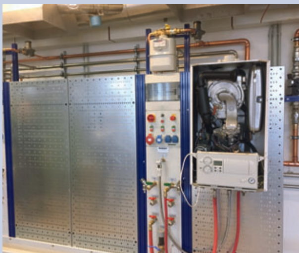
Kurz vor der Fertigstellung
