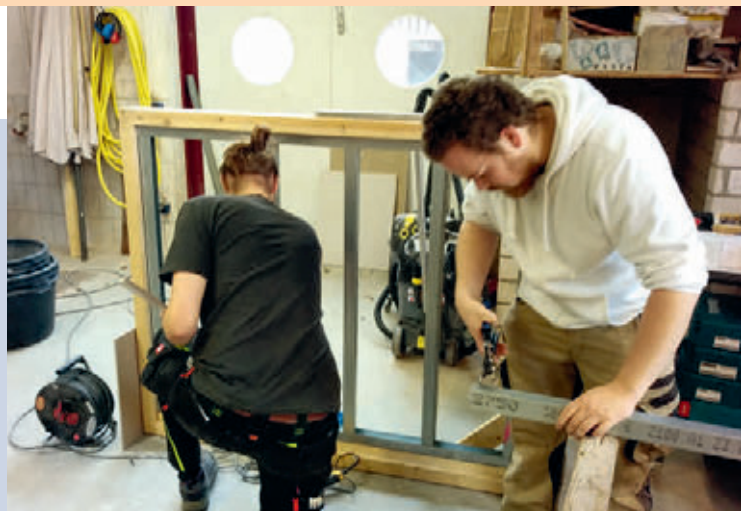
Schüler bei der Konstruktion einer Trockenbauwand
