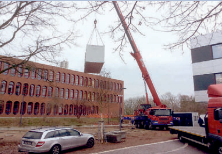
Containeraufstellung, unsere zukünftigen Klassenzimmer
