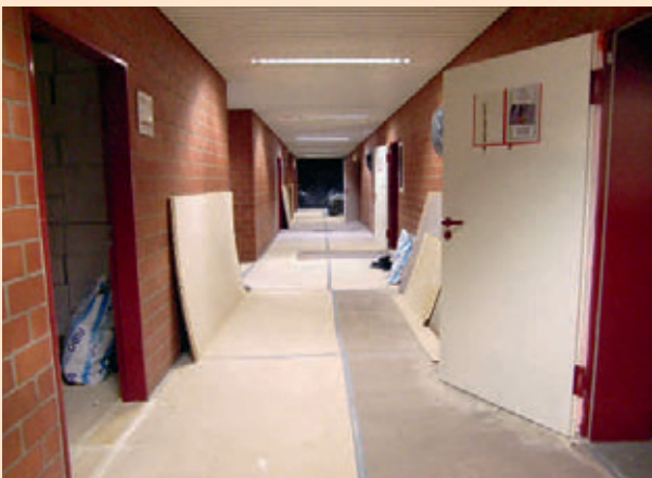
Baustelle auf dem Flur
