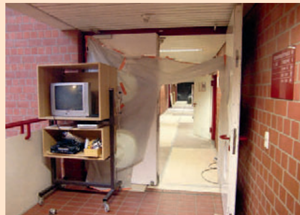
Eingang zur Baustelle mit Blick in den Flur
