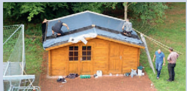
Arbeiten am Geräteschuppen
