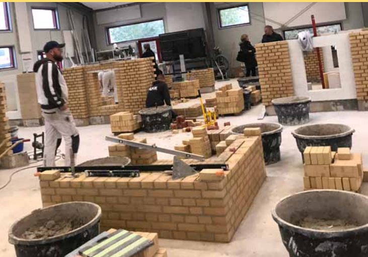
Bauhalle im EUC
